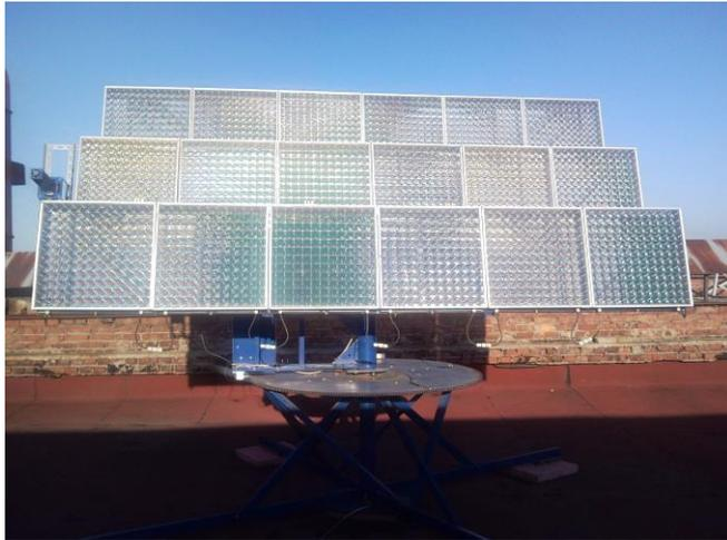
Фотоэнергоустановка на трекере башенного типа
