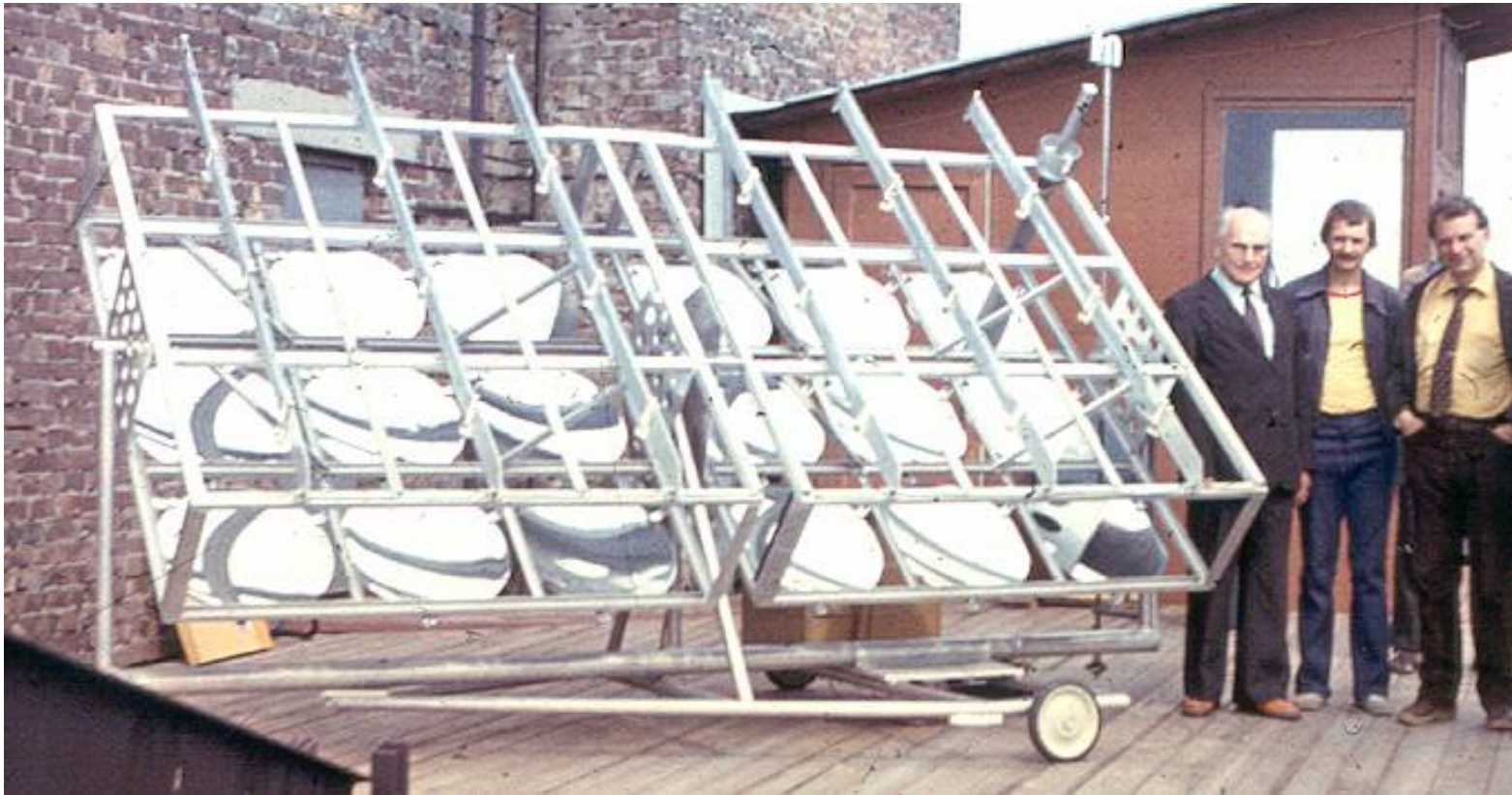
Солнечная установка на основе AlGaAs/GaAs фотоэлементов с зеркальными концентраторами излучения. Справа - Ж.И.Алферов, в центре – В.Д.Румянцев, слева – В.М.Тучкевич
