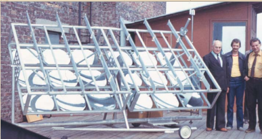
Рис. 3. Солнечные энергоустановки на основе гетероструктурных \text{AlGaAs}/\text{GaAs} фотопреобразователей и зеркальных концентраторов на крыше ФТИ (1981 год). Стоят слева направо: акад. В. М. Тучкевич, проф. В. Д. Румянцев, акад. Ж. И. Алферов)
